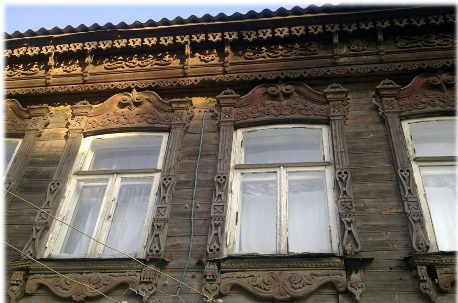
Фасадные наличники 2 этажа
